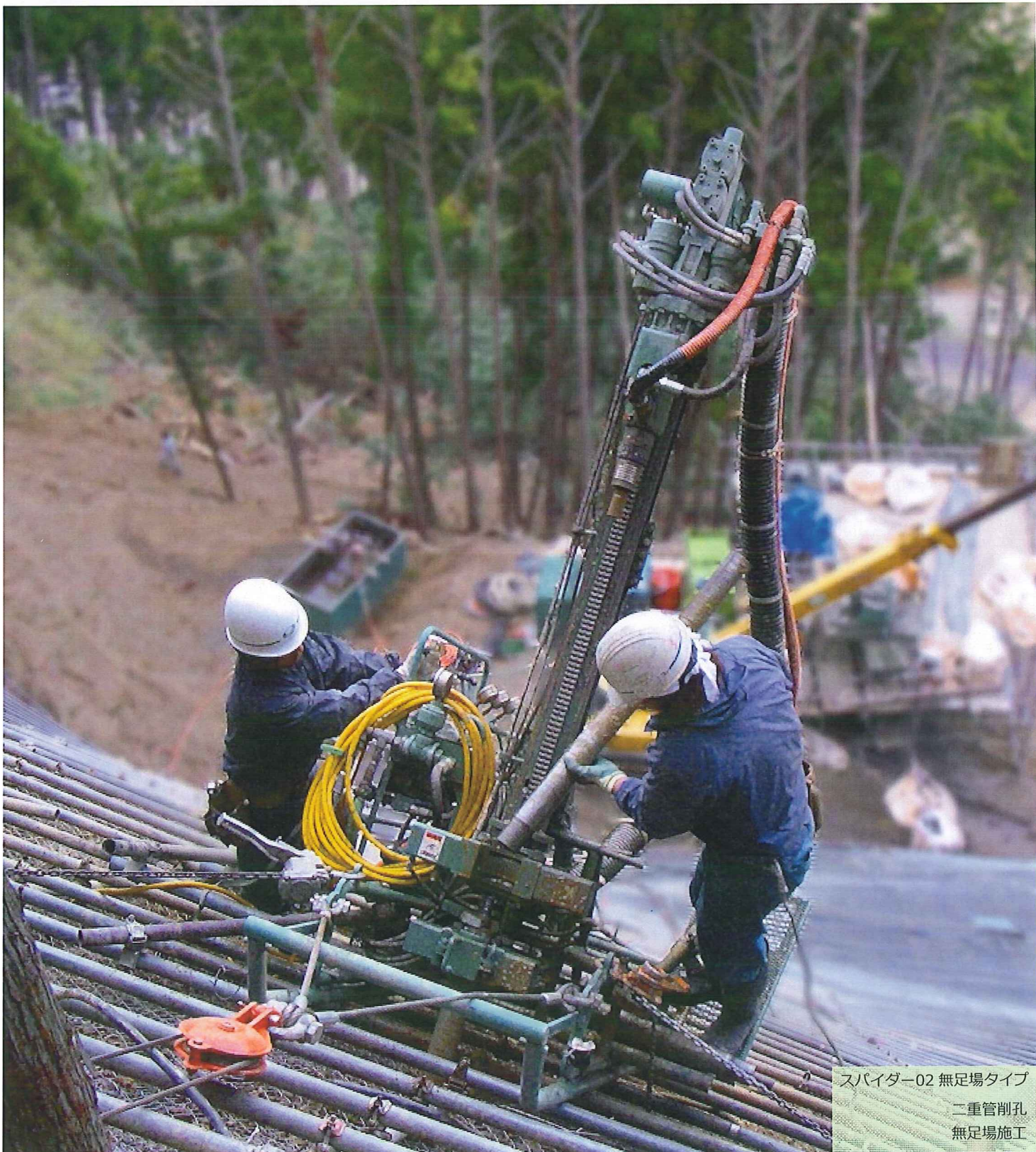
スパイダー02 足場タイプ 二重管削孔 足場幅 2m
